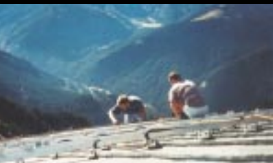
Montage der Solartechnik an der Tölzer Hütte
